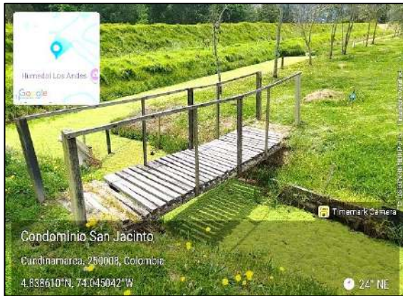
VISTA ÁREA REQUERIDA, PUENTE PEATONAL M21, M22.
