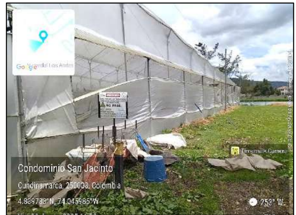
VISTA ÁREA REQUERIDA, INVERNADERO 1
