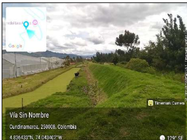
VISTA ÁREA REQUERIDA CANAL, ZONA VERDE, JARILLÓN M18. LÍNEA DE VIDA M23
