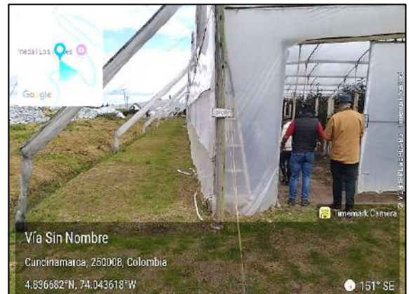
VISTA ÁREA REQUERIDA, INVERNADERO 7
