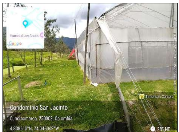
VISTA ÁREA REQUERIDA, INVERNADERO 4
