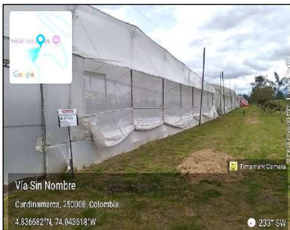
VISTA ÁREA REQUERIDA, INVERNADERO 7
